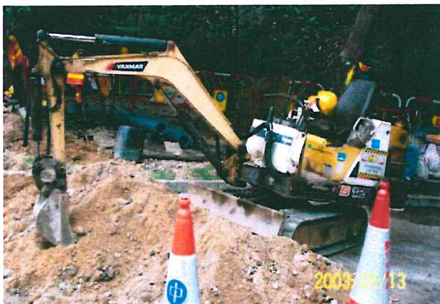
Mini Excavator 小型挖土機
